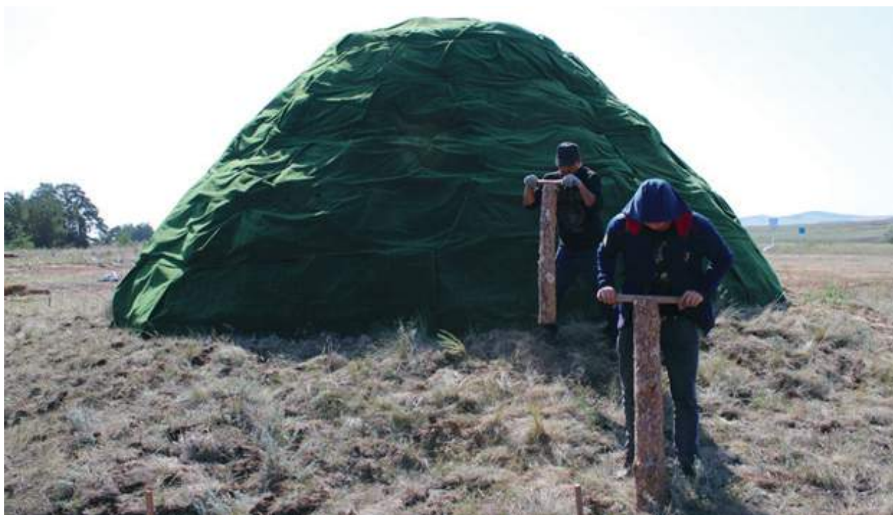
Сур. 5. Ботай ғылыми-эксперименталды тұрғын үйін гидрооқшаулау (гидроизоляция), бөренелермен нығыздау жұмыстары.
