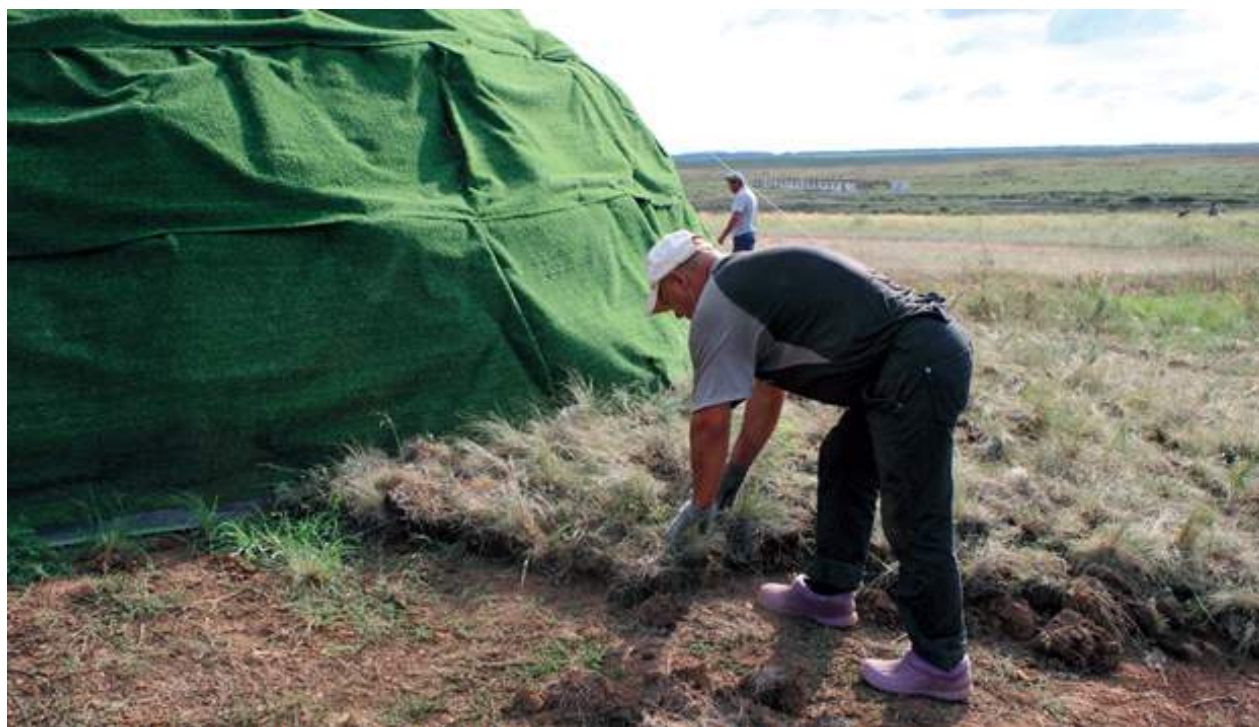
Сур. 6. Ботай ғылыми-эксперименталды тұрғын үйін гидрооқшаулау (гидроизоляция) жұмыстары.
