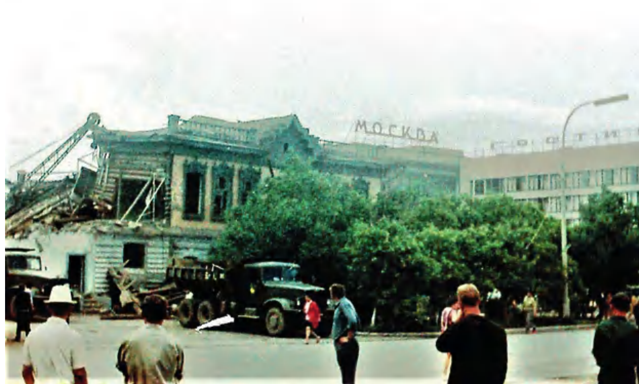
Рис.6. Снос дома Халфина. Фото из открытых источников.
