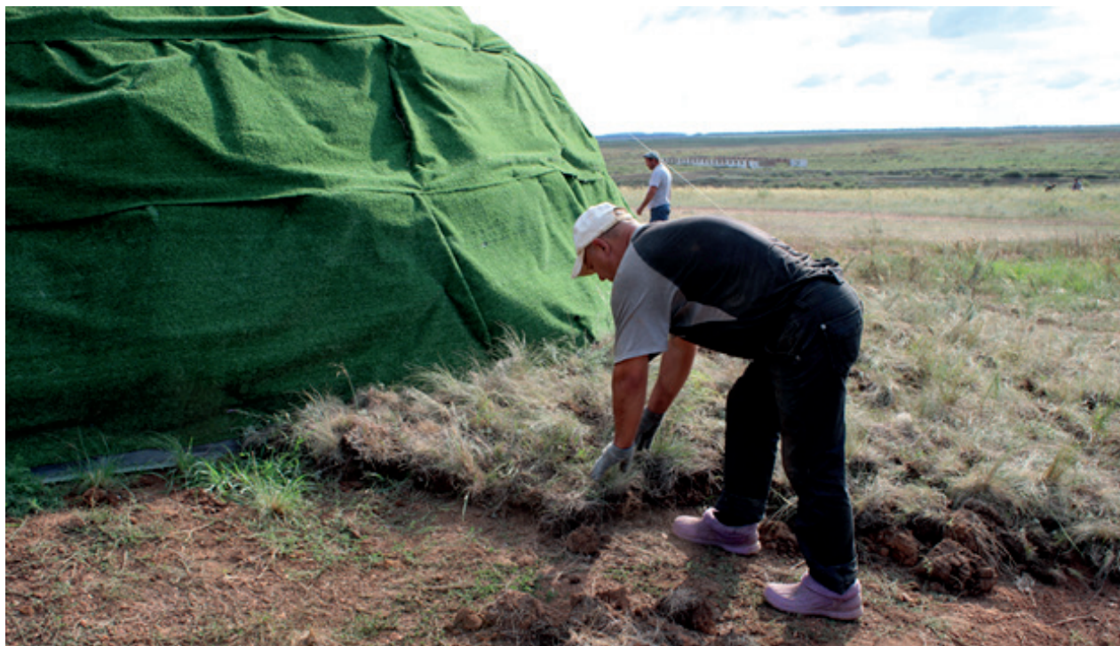
Сур. 6. Ботай ғылыми-эксперименталды тұрғын үйін гидроқшаулау (гидроизоляция) жұмыстары.
