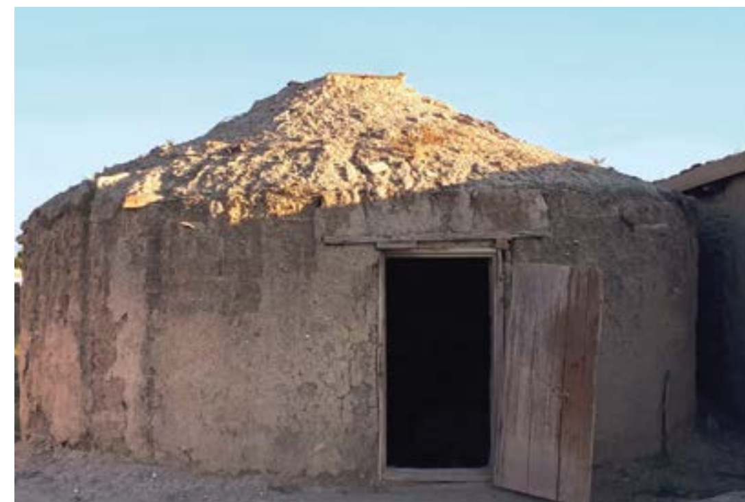
Сур. 1. Қалжыр ауылындағы саман кірпіштен салынған тошала Fig. 1. A construction of sun-dried bricks in Kalzhyr village
